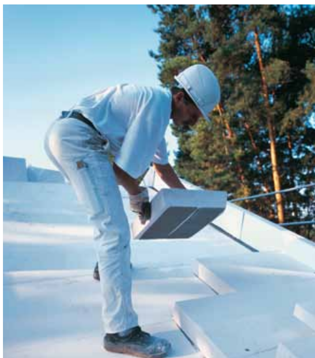
Isolering av lutande tak med Ytong Multipor Isoleringsplattor
